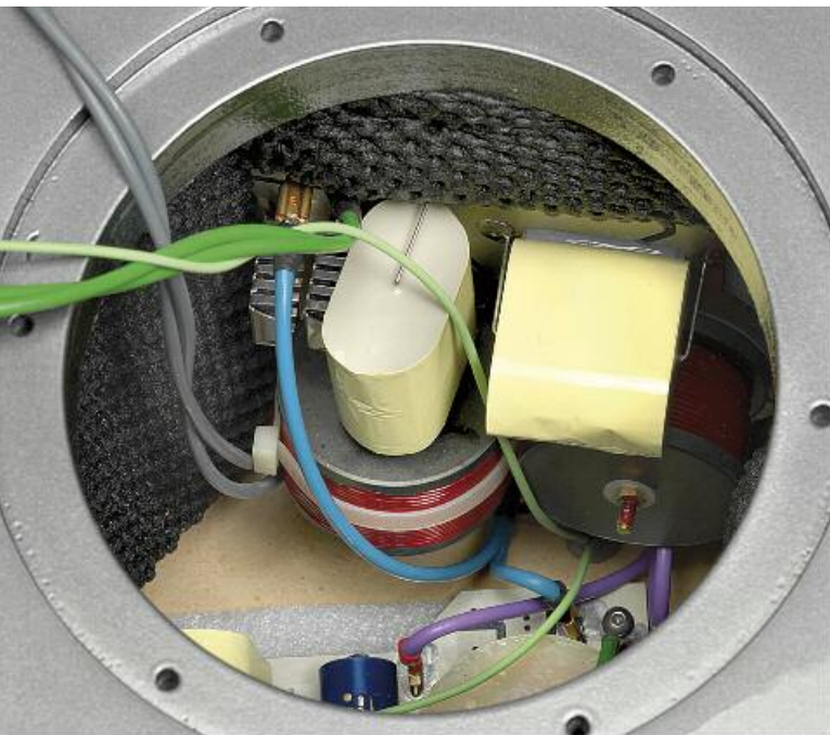
Frequenzweiche, die Erste. In diesem Fall die Abteilung für den Tiefmitteltöner. Es macht Sinn, die beiden Weichenabteilungen voneinander zu trennen
